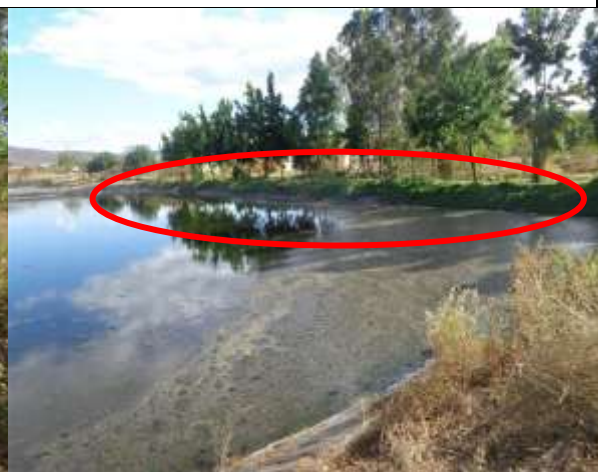
Foto 5 Ausência de limpeza e capina da ETE
