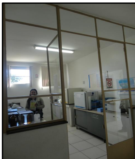
Foto 03 – Instalações do laboratório.
