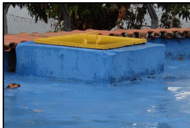
Foto 14: Tampa do reservatório sem trava de fechamento ou cadeado.
