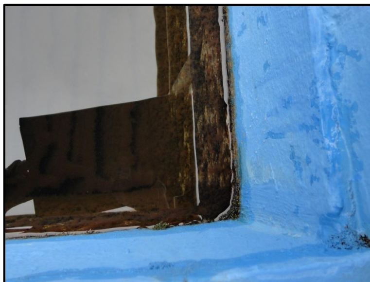
Foto 05: Acúmulo de sujeira nas placas do decantador.
