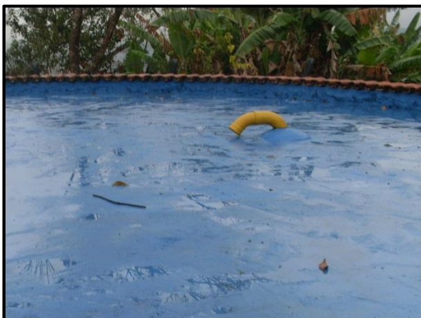
Foto 11: Tubo de ventilação sem tela de proteção no RSE - 06
