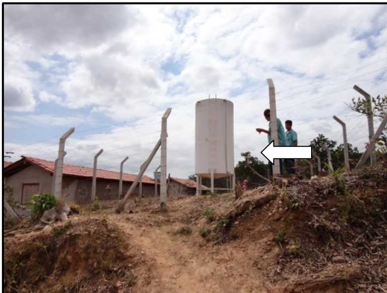
Foto 11: Entrada do REL-01 sem portão e sinalização.
