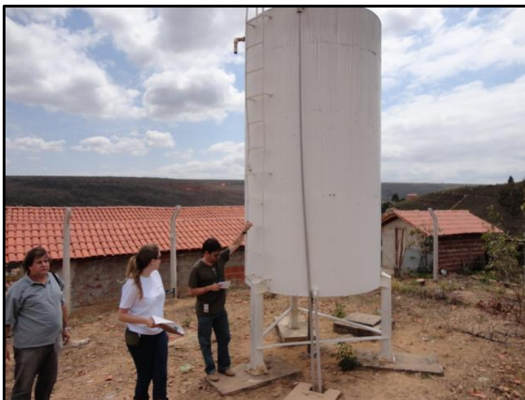
Foto 12: Escada sem proteção
