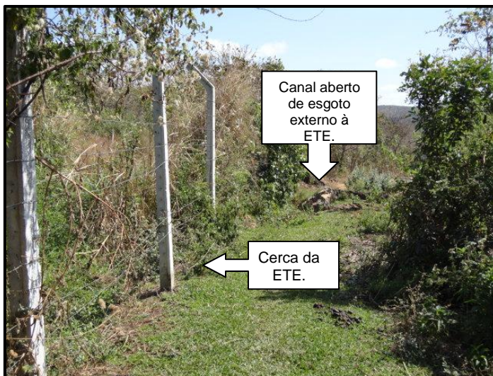
Foto 18: Limite entre a cerca da ETE e o canal aberto do esgoto tratado.
