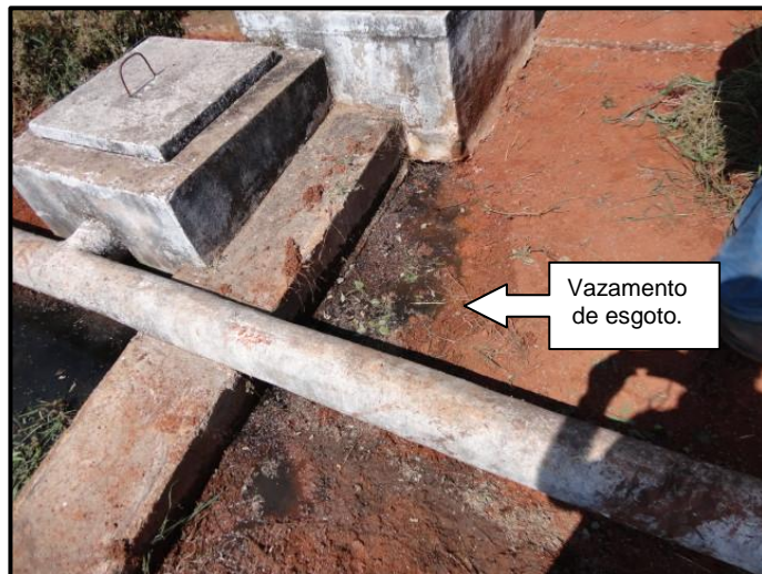
Fotos 25 e 26: Vazamentos de esgoto nas tubulações de saída dos RAFA's
