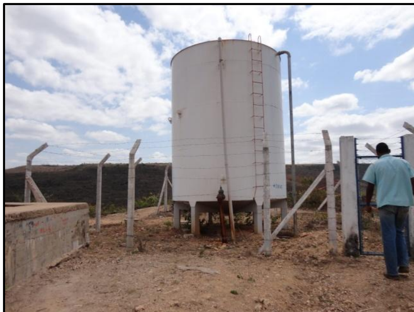
Foto 13: Entrada da REL-02 sem sinalização e Identificação
