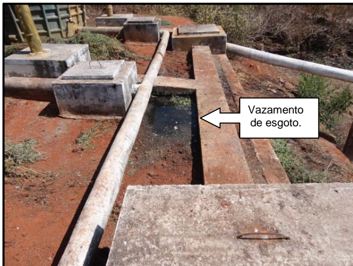
Fotos 25 e 26: Vazamentos de esgoto nas tubulações de saída dos RAFA's
