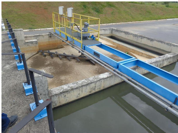
Foto 3. Desarenador inoperante (C2.1)
