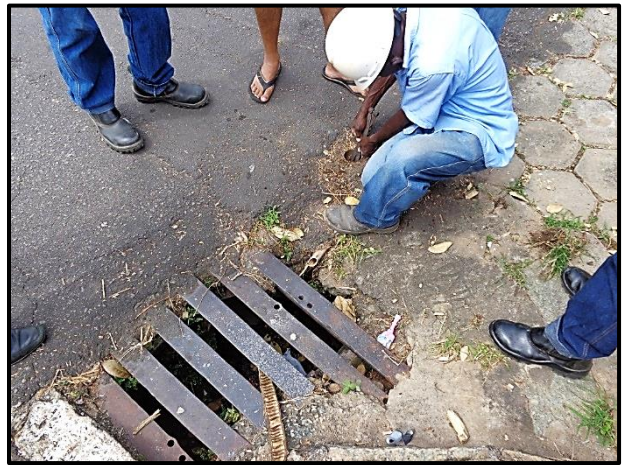
Imagem 2. Realização da descarga de rede.
