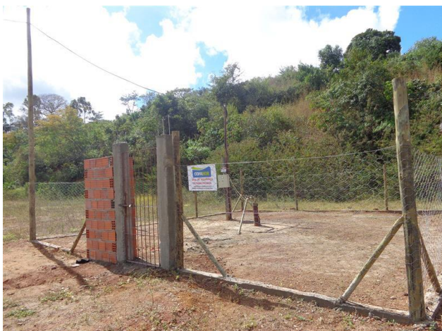
Foto 5. Ausência de placa de identificação no Poço C-03.
