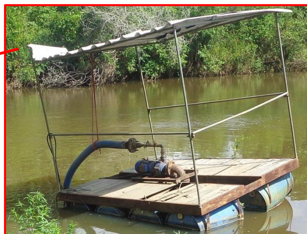
Foto 4. Ausência de bomba reserva (C1.2)
