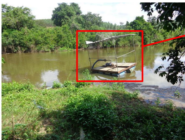
Foto 3. Balsa da captação Rio Pampã (C1.2)
