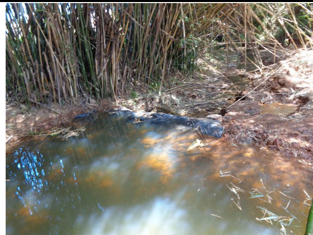
Foto 2. Barragem improvisada para elevar o nível de captação
