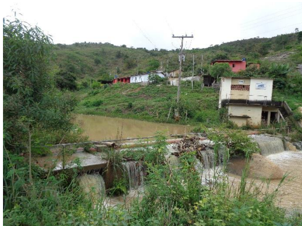
Imagem 5. Barragem de nível - Córrego São José
