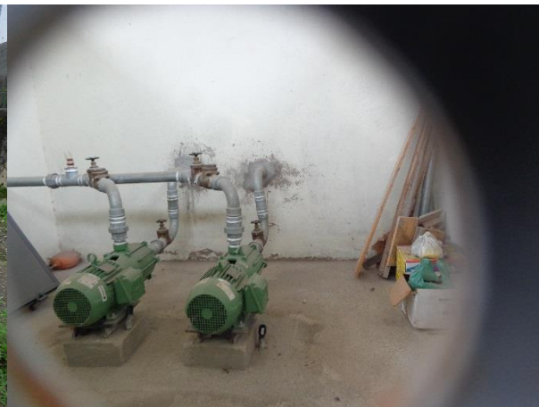
Imagem 15. Conjunto moto-bomba EAT 2 – lagedo em fase de instalação
