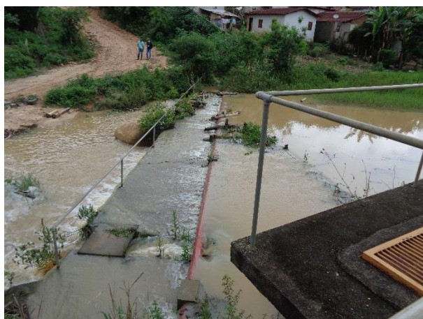
Imagem 7. Barragem de nível - Córrego São José
