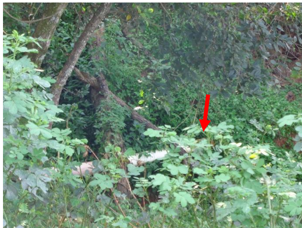
Foto 2 - Vista da rede coletora de esgotos - final da rua Antônio Atanásio.
