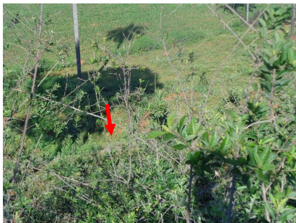
Foto 3 - Poço de visita observado a partir da rua Belo Horizonte.
