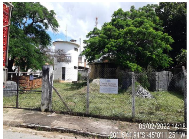
Foto 12. Vista geral da ETA
