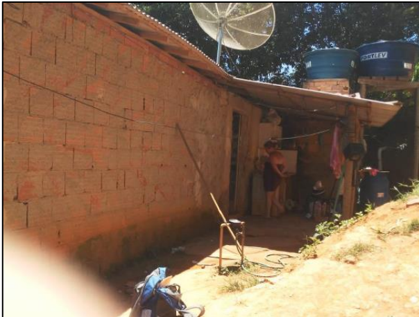
Foto 7. Rua da Torre, 65
