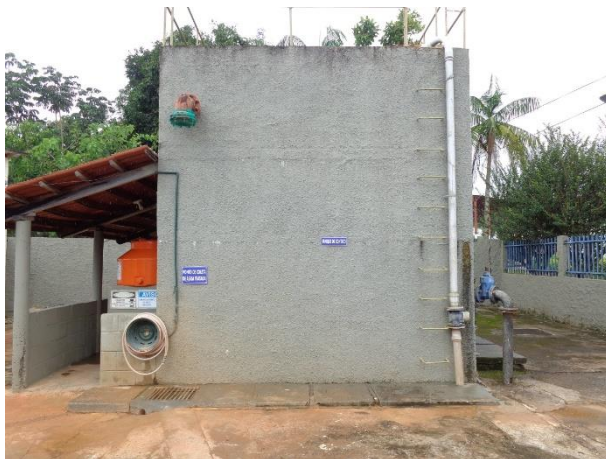
Foto 3. Tanque de Contato
