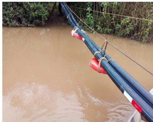
Foto 3. Nova adutora sobre rio Sapucaí-Mirim
