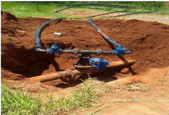
Foto 2. Interligação da rede construída à rede existente
