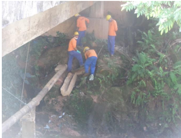
Imagem 1. Manutenção no interceptor de esgotos
