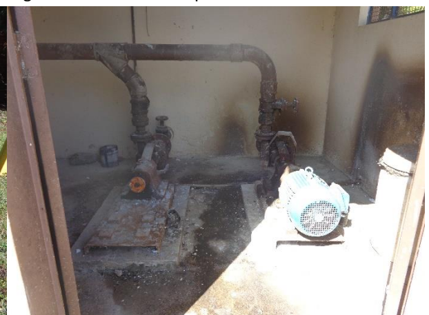
Imagem 6. EEE 04 - Estação elevatória de esgotos Esplanada
