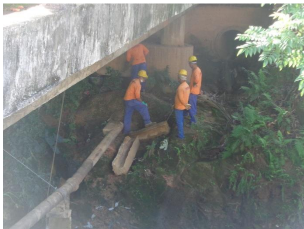
Foto 3 - Manutenção interceptor de esgotos sob a ponte Ademar da Silva Neiva (Córrego Pobre)
