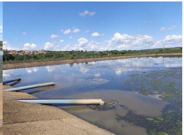
Imagem 12. ETE - Lagoa anaeróbia
