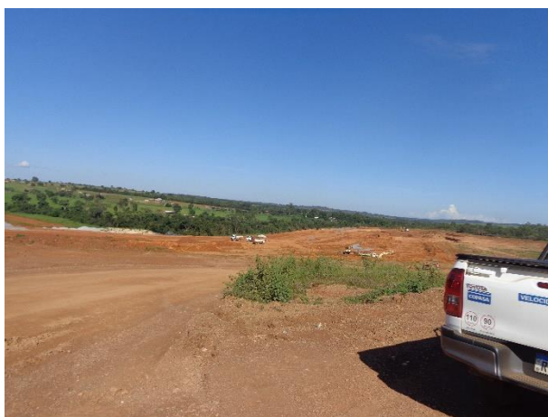
Foto 2. Obras de implantação do reservatório de água bruta – piscinão. .
