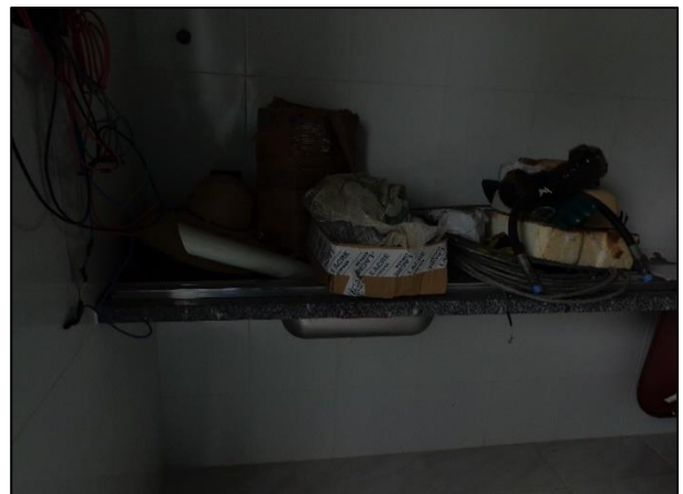
Figura 4. Obras na cozinha
