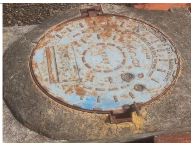
Foto 4. Tampa de inspeção – R02
