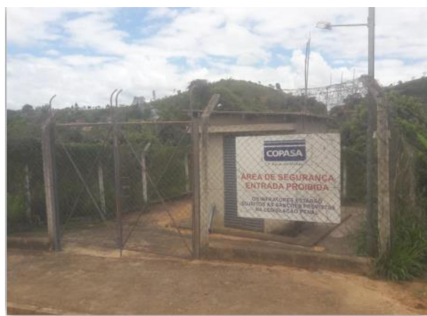
Foto 2. Elevatória de Água Tratada
