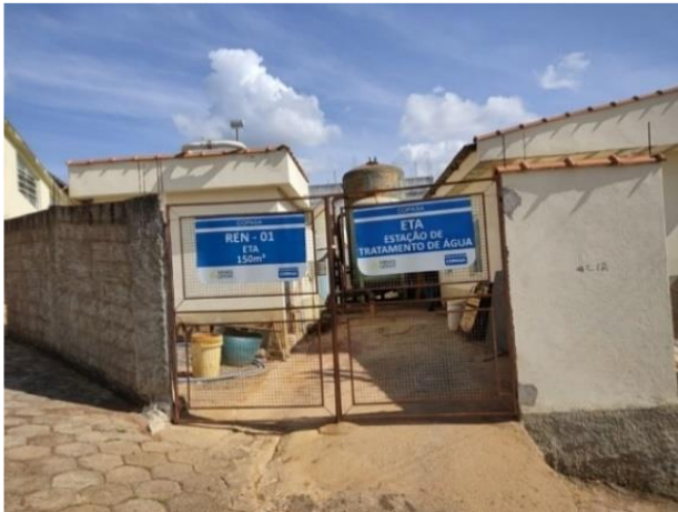
Foto 7. Entrada da ETA
