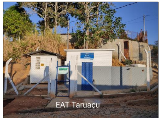
Foto 2. Estação elevatória de Água Tratada
