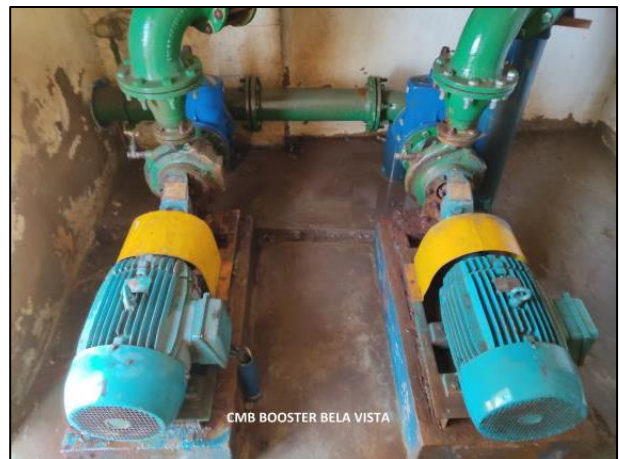
Foto 22. Booster Bela Vista - Conjuntos moto-bomba
