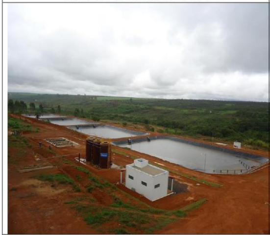
Lagoas de Tratamento Anaeróbico - ETE
