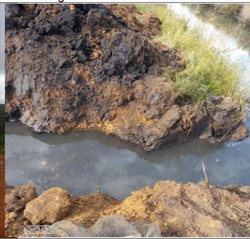
Ponto de Lançamento - ETE
