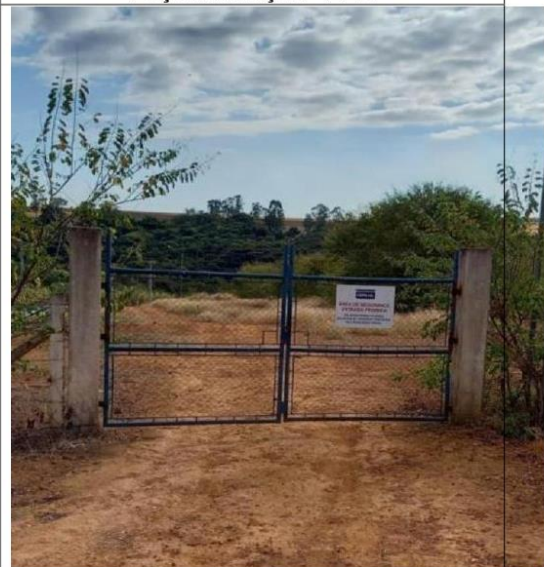
Acesso e placa de identificação - ETE
