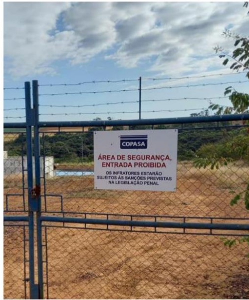
Placa de Advertência - ETE
