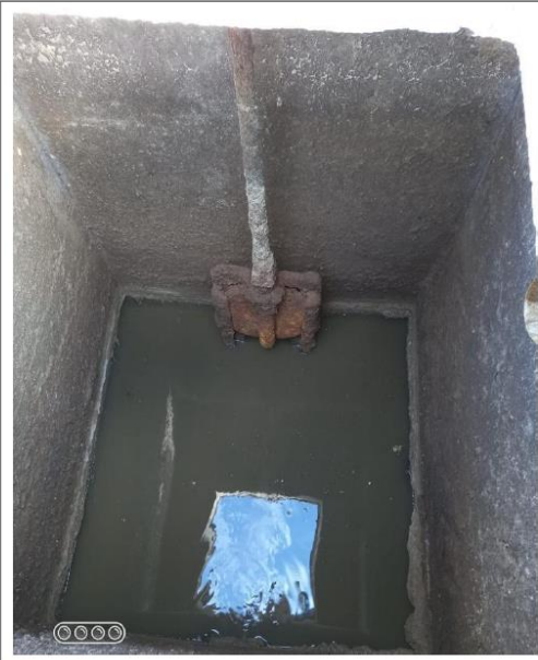
Poço de sucção - EEE
