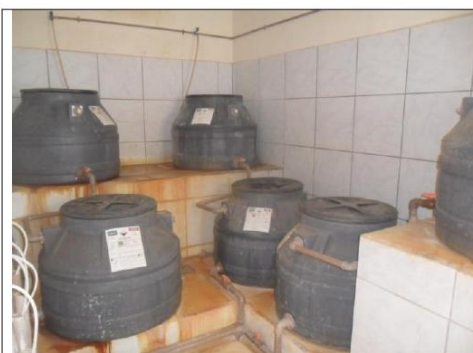
Casa de Química - ETA
