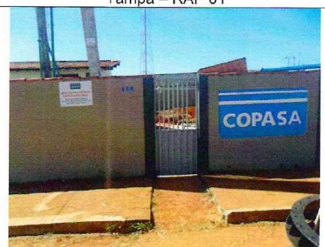
Muro - RSE 02 e 03, REL 04
