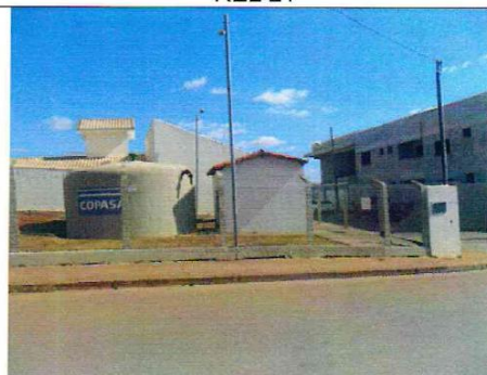
Cercamento - RAP 12 e REL 13
