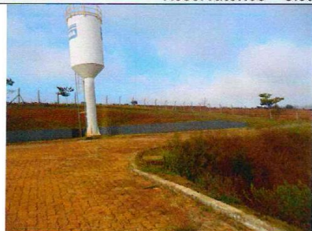
REL Lavagem dos filtros
