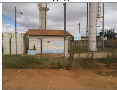
Cercamento – RAP 01, REL 02 e 03
