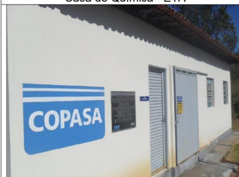
Casa de química - ETA
