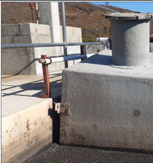
Foto 1. Suporte de fixação da coifa frágil
